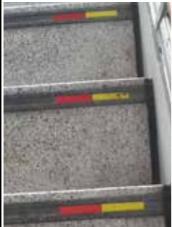
駅の階段にある階段識別マーク
